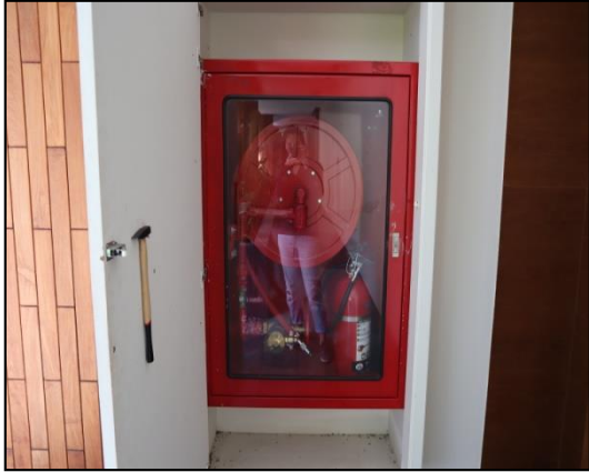
ภาพที่ 1-18 ตู้เก็บอุปกรณ์ดับเพลิง และสายส่งน้ำ
