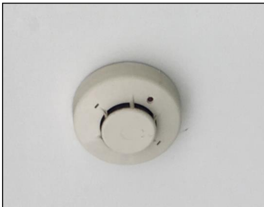
ภาพที่ 1-17 เครื่องตรวจจับควัน และเครื่องตรวจจับความร้อน
